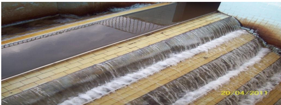
KÜÇÜKLER BARAJI İÇME SUYU ARITMA TESİSİ HAVALANDIRMA ÜNİTESİ
