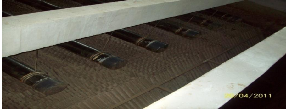
KÜÇÜKLER BARAJI İÇME SUYU ARITMA TESİSİ HAVALANDIRMA ÜNİTESİ
